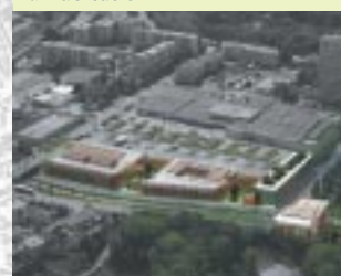
Le projet d'aménagement du centre commercial La Cascade conjugue embellissement et accessibilité
