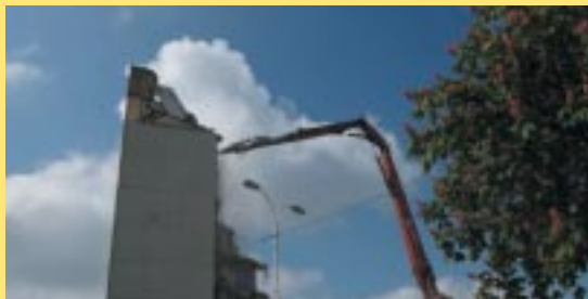
Démolition du Marronnier rouge au Haut-du-Lièvre
