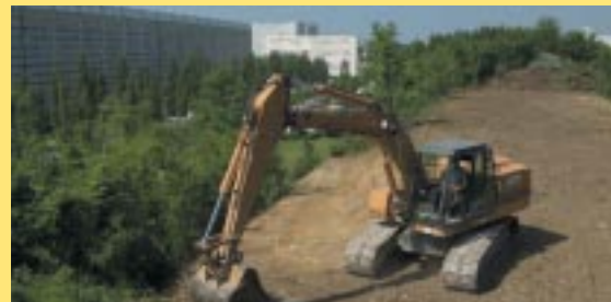
Les pelleteuses en action sur le haut du merlon
